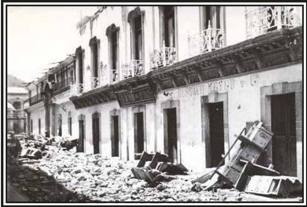
Ilustración 52: Estado en que quedó el Edificio de Casa Aparicio después del Terremoto de 1902.
