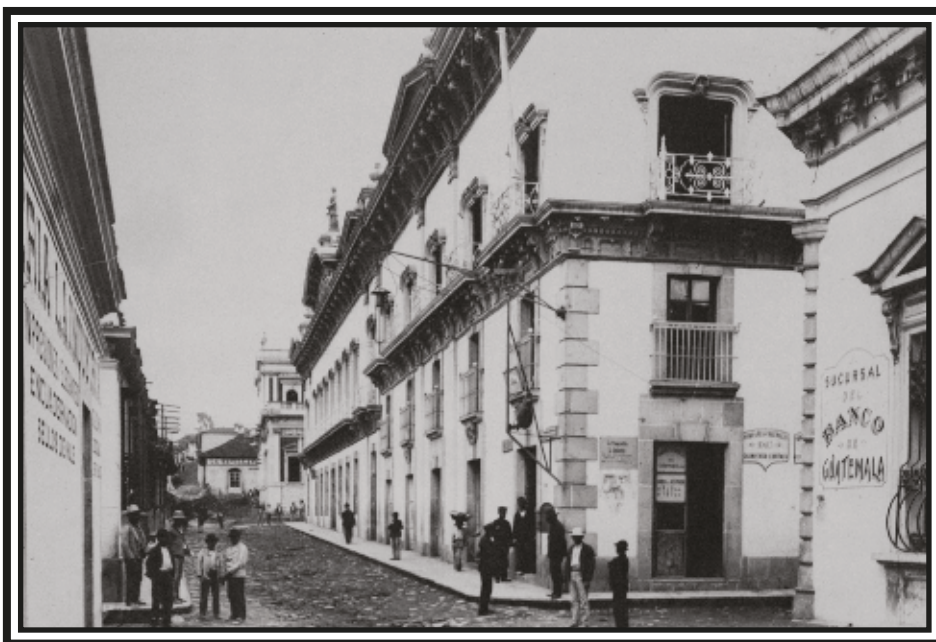
Ilustración 47: Edificio de Casa Aparicio antes del terremoto del 18 de Abril de 1902
